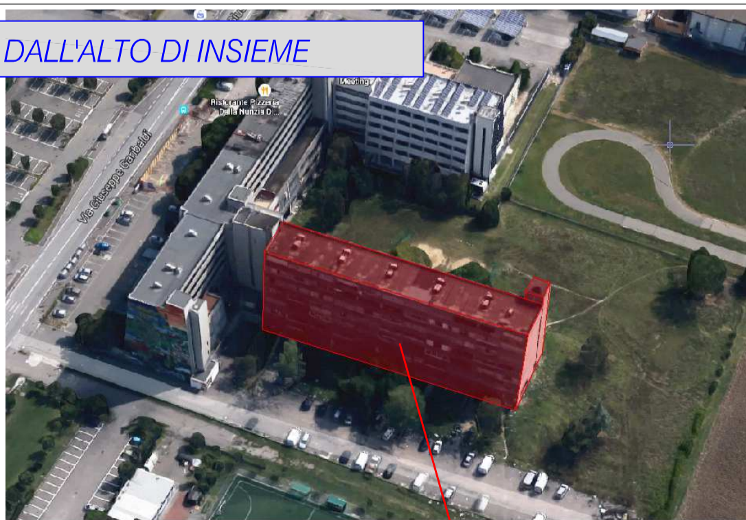
parte oggetto di demolizione
